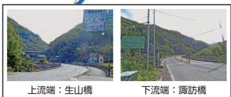
上流端: 生山橋
